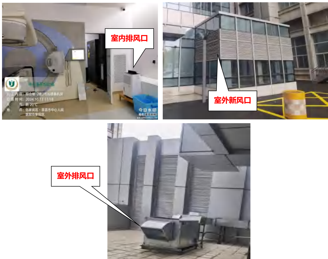
图 3.1-9 2#加速器机房通风情况现场照片
