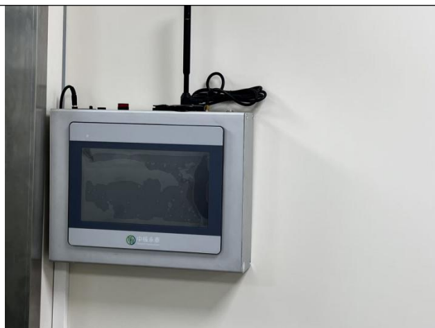
辐射剂量监控系统 放射性药物生产区部分辅助屏蔽设施现场照片
