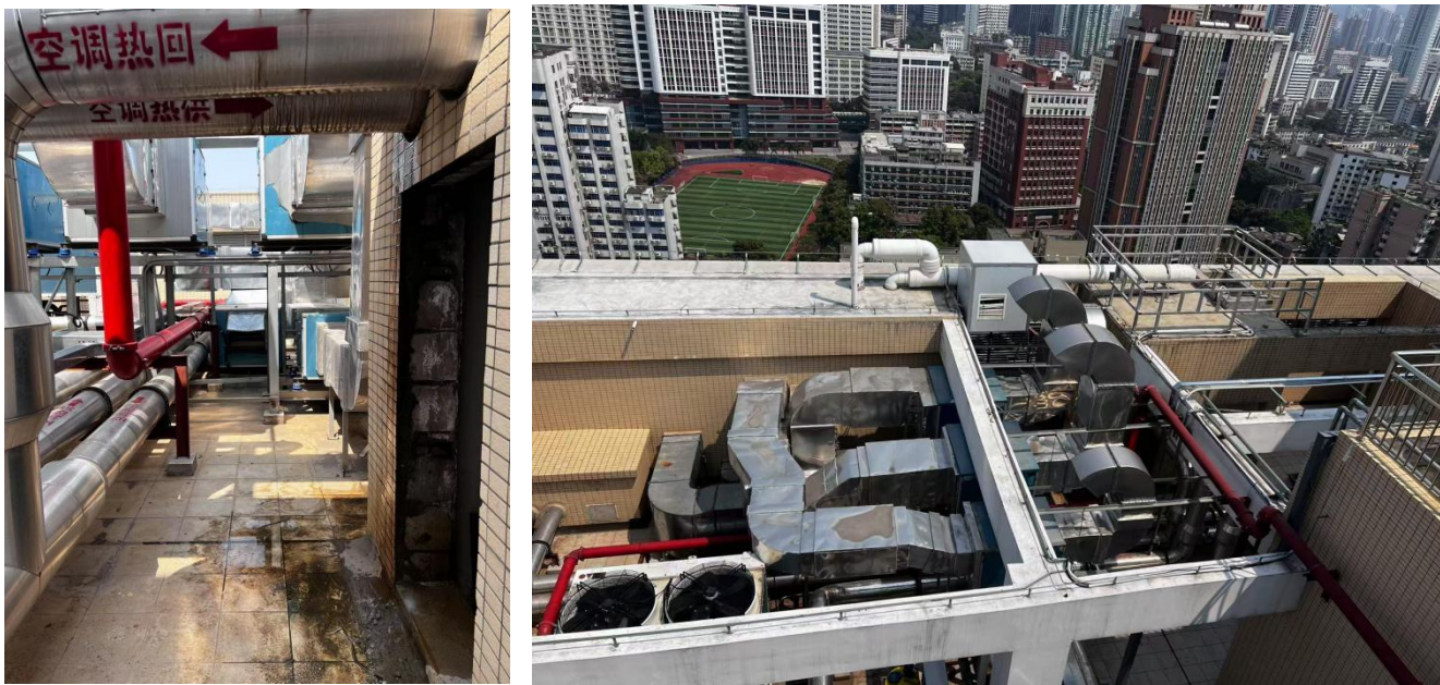
图 3-14 排风管道照片
